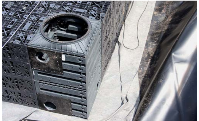
In den EcoBloc Verbund ist das Schachtsystem Vario 800 passgenau integriert.
