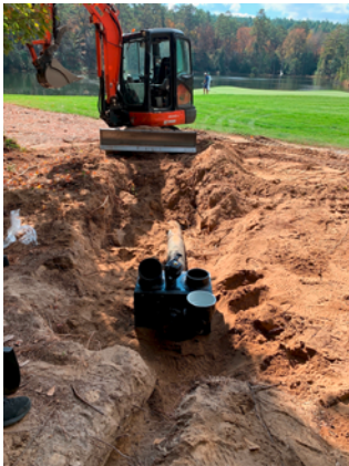
Die Installation der SubAir-Systeme kann während des laufenden Spielbetriebs erfolgen. (Fotos: SubAir)
