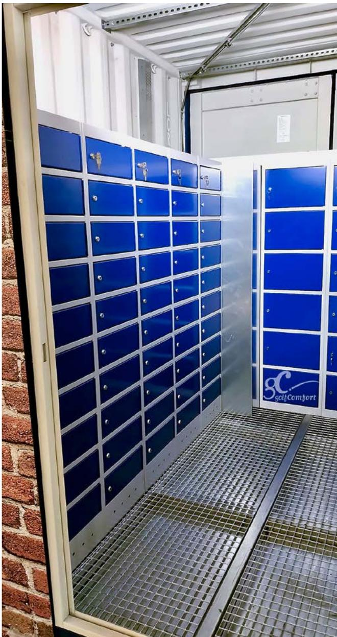
Im Inneren der Container: die Ladefächer mit darin verbauten Lademöglichkeiten. Mittels einer Gel-Löschanlage werden die Container soweit gekühlt, dass sie einem Feuer standhalten und ein Übergriff auf angrenzende Gebäude vermieden wird.
