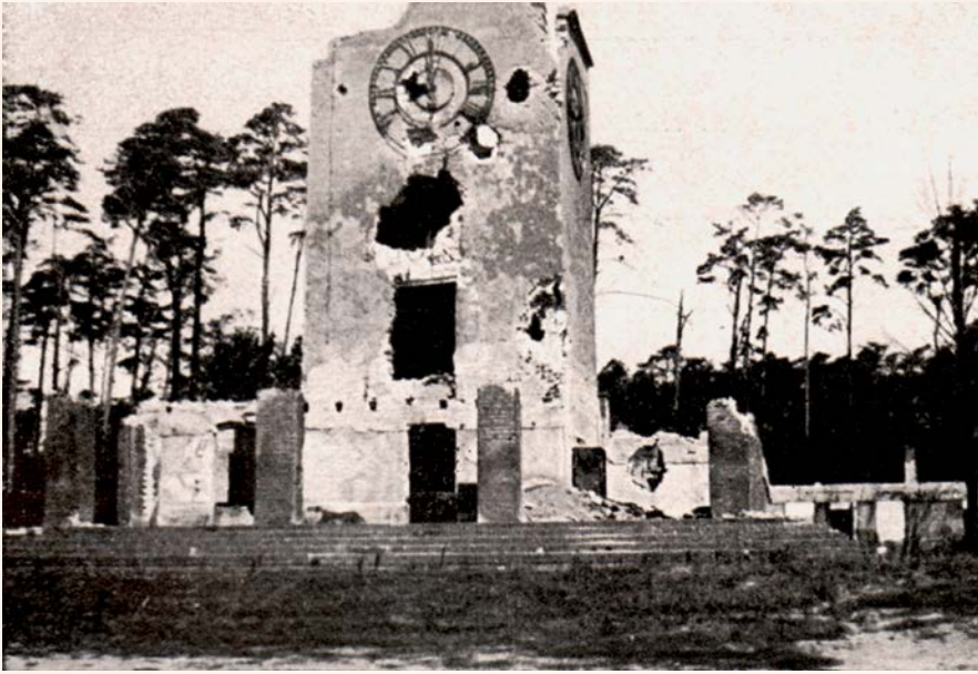
Der im Krieg stark beschädigte Uhrenturm in Wannsee
