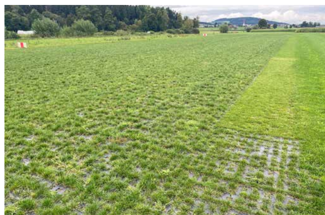
Foto 7: Rasengitter-Armierung der Rasenpiste am Flugplatz Luzern-Beromünster
