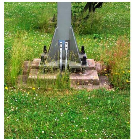
Abb. 5: Kanten von festeingebauten Elementen führen zur Nacharbeit.
