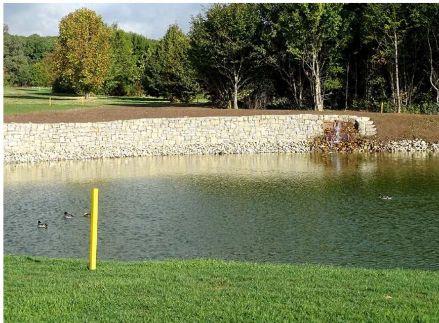
Abb. 1: Erweiterter Beregnungs-Teich mit massiver Steinmauer und Wasserzufluss bis 10.000 m<sup>3</sup>.
