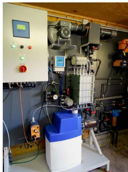
Abb. 2a+b: Greensaver-Anlage zur Behandlung des eingesetzten Brauchwassers.
