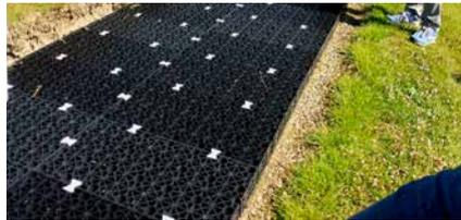
Abb. 2: Bauweise mit Kunststoffmodulen „Permavoid“ unter Rasenflächen bei STRI. (Foto: W. Prämaßing)
