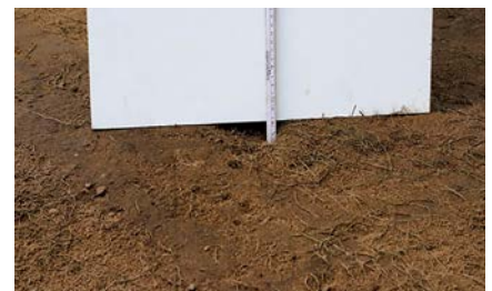
Abb. 10: Glatte Fasern liefern beim Abfräsen einer Hybrid-Tragschicht eine bessere Ebenflächigkeit.
