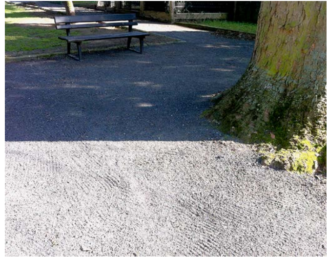
Abb 4: Wassergebundener Weg mit Stabilizer, 1 Jahr nach dem Einbau.
