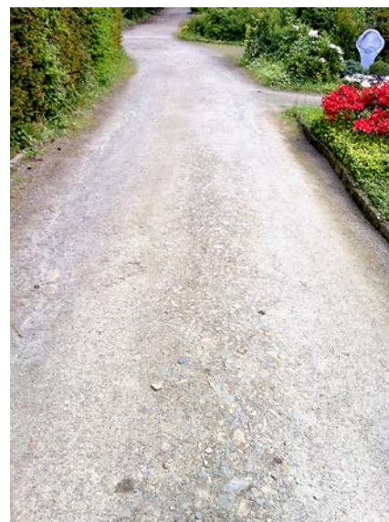
Abb. 2: Starke Verformung und Glatzenbildung.
